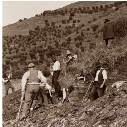
Fig. 8. Surriba, Quinta de Santa Bárbara. Casais do Douro, Ervedosa, S. João da Pesqueira. Note-se a diversidade de ferramentas empregadas pelos trabalhadores: o ferro, as pás e, no canto esquerdo, a maceta
