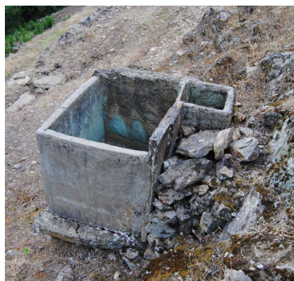
Fig. 51. Tanque para preparação de caldas, com reservatório para dissolução de sulfato de cobre. Requeixo, Pereiros, Carrazeda de Ansiães
