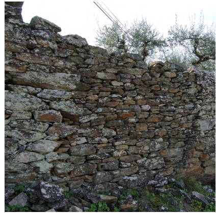
Fig. 17. Pormenor de reconstrução. Caminho da Quinta do Tua, Foz Tua, Carrazeda de Ansiães
