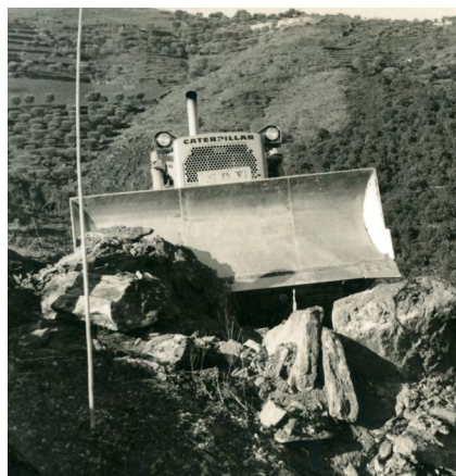
Fig. 29. Demonstração no Douro do trator Poly Bob (1971). Surriba com Caterpillar, na Quinta do Bom Retiro (1966). Fotos: António Grácio, col. Museu do Douro
