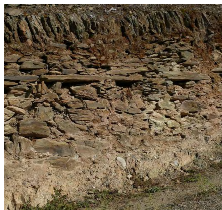
Fig. 36. Pilheiros. Quinta do Síbio, Cotas, Alijó. Além dos pilheiros note-se o reforço em pilha do remate do muro
