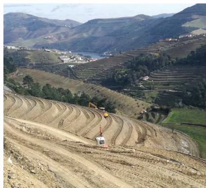
Fig. 31. Trabalhos de surriba. Quinta do Junco, S. Cristóvão do Douro, Sabrosa
