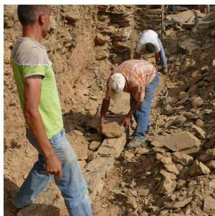
Fig. 9. Construção do alicerce. Quinta da Romaneira, Cotas, Alijó
