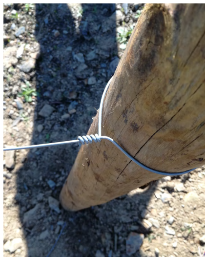
Fig. 39. Remate do arame feito pelo Sr. Rombóia. Quinta de Ventozelo, Ervedosa do Douro, S. João da Pesqueira
