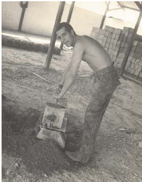
Figura 15. Fabrico de tijolos para a construção de casernas. Gago Coutinho.
